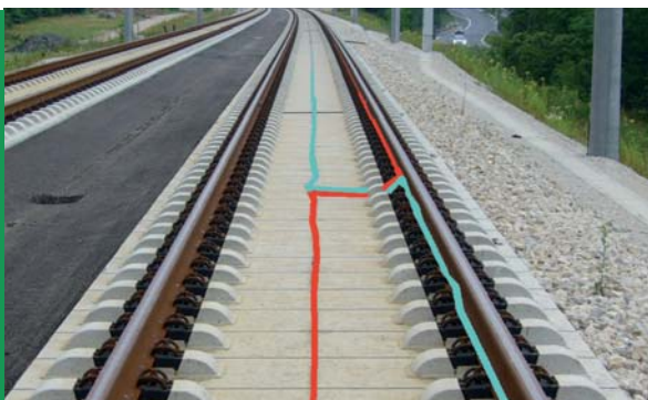
Lage der Linienleiter im Gleis. Dargestellt ist eine Kreuzungsstelle.
